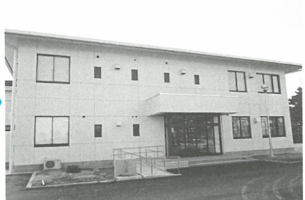
復旧後（組合事務所）
